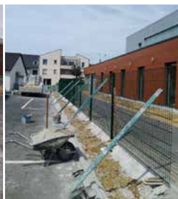
Pose des nouveaux grillages dans la tranchée végétalisée
