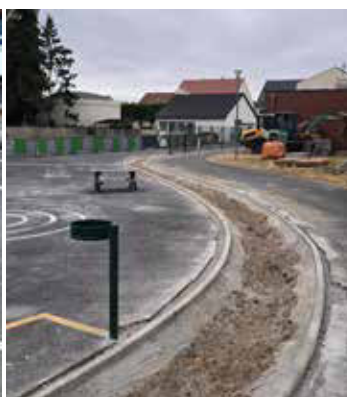
Pose des nouvelles bordures
