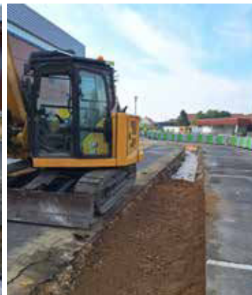
Préparation de la terre végétale
