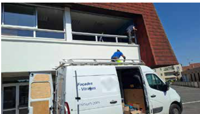
Prise de mesure et pose des nouvelles fenêtres dans les classes élémentaires
